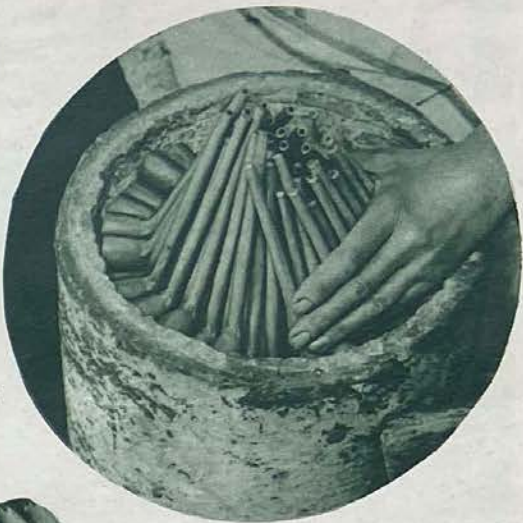
Les pipes sont placées dans des creusets en pierre réfractaire.
